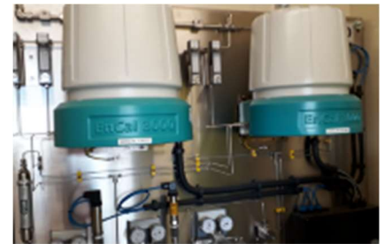
Analyseurs chromatographe du poste -Crédit photo GRDF
