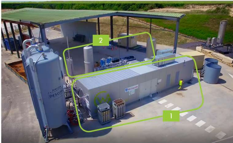
WAGA BOX installée sur le site ISDND de Saint-Maximin
