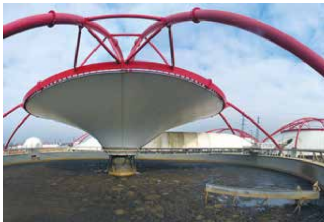
Plusieurs stations d'épuration intègrent désormais un méthaniseur au sein de leur site afin de valoriser leurs boues d'épuration.
