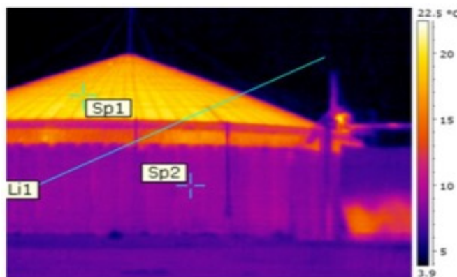
Déperditions thermiques sur un digesteur voie liquide
