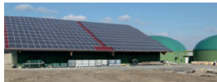
Installation PV sur bâtiment agricole - © Opale Energies Naturelles
