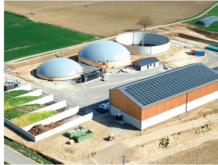
Site de méthanisation avec installation photovoltaïque © Ariège biométhane
