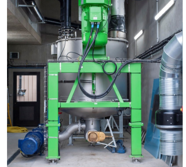
Le Kreiss Dissolver pour préparer la matière.
