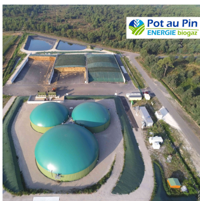
Vue aérienne du site de méthanisation
