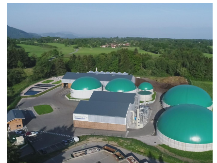
Vue aérienne du site de Terragr'Eau
