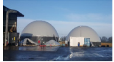
Digesteur et post-digesteur de l'unité de méthanisation
