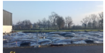
Lagune de 5 500 m 3 pour stocker le digestat liquide
