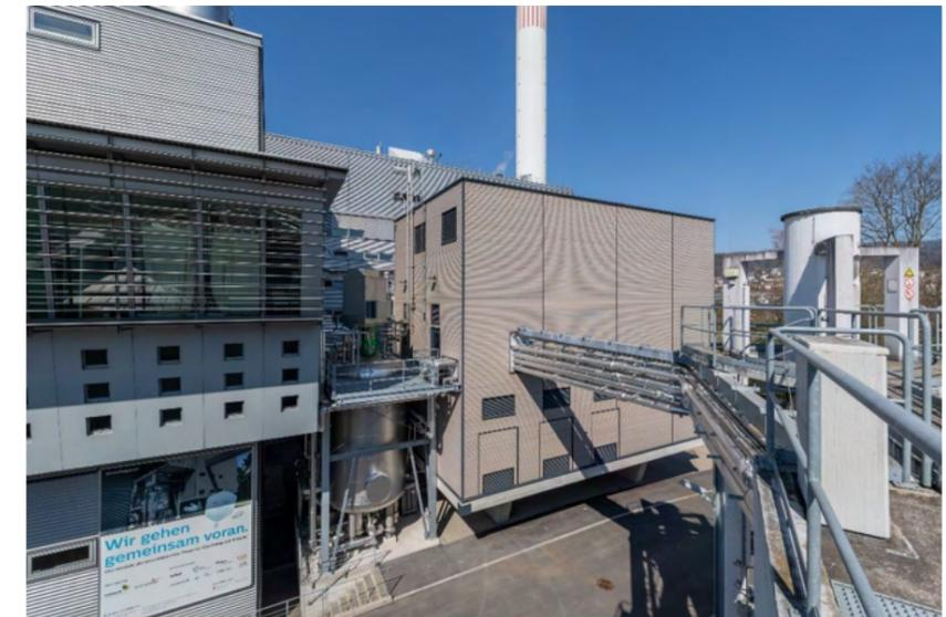
**Photo de l'usine de Dietikon. Le réacteur de méthanation biologique à gauche du bâtiment en bois. Ce bâtiment contenant les électrolyseurs, la gestion de l'unité ainsi que le local électrique**
