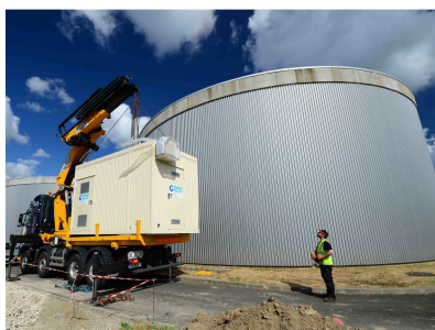
Livraison du poste d'injection
