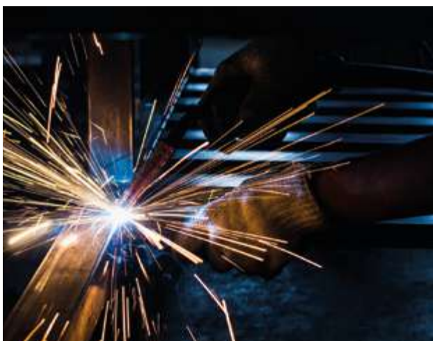
Opération de travail par point chaud
