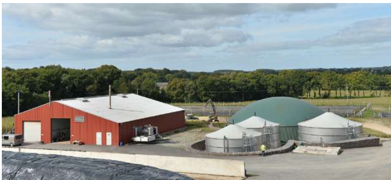
Vue aérienne d'une installation de méthanisation agricole.
