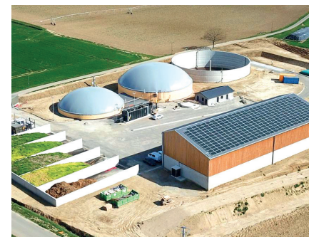
Site de méthanisation avec installation photovoltaïque © Ariège biométhane
