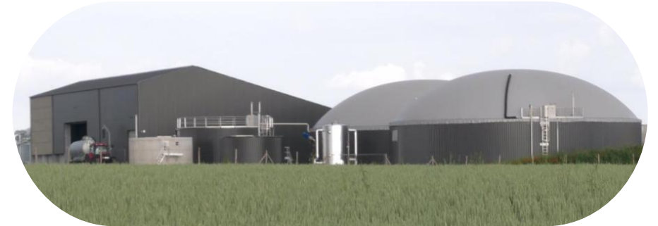
Site de méthanisation Déméter Energies à Prin-Deyrancon (79) qui prévoit de basculer de la cogénération à l'injection dans les réseaux
